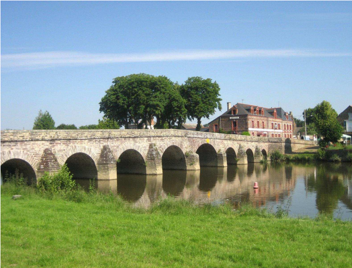
Pont de Pont-Réan (Ille-et-Vilaine) (cl. Wikipedia Commons 3.0. Maarten Sepp, 2012)
